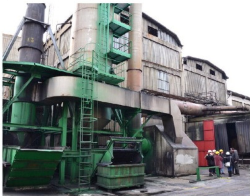
Lo stabilimento delle Fonderie Pisano
