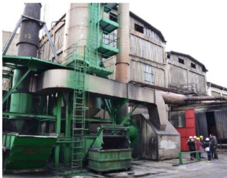
Lo stabilimento delle Fonderie Pisano
