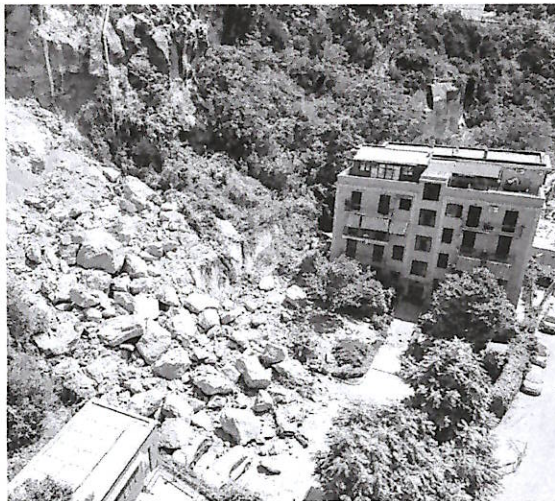
Il costone crollato a causa della scossa avvenuta lo scorso 31 luglio
