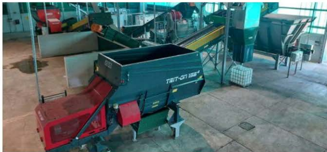
L'impianto di compostaggio di Salerno
