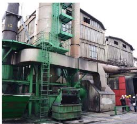
Lo stabilimento di Fratte delle Fonderie Pisano
