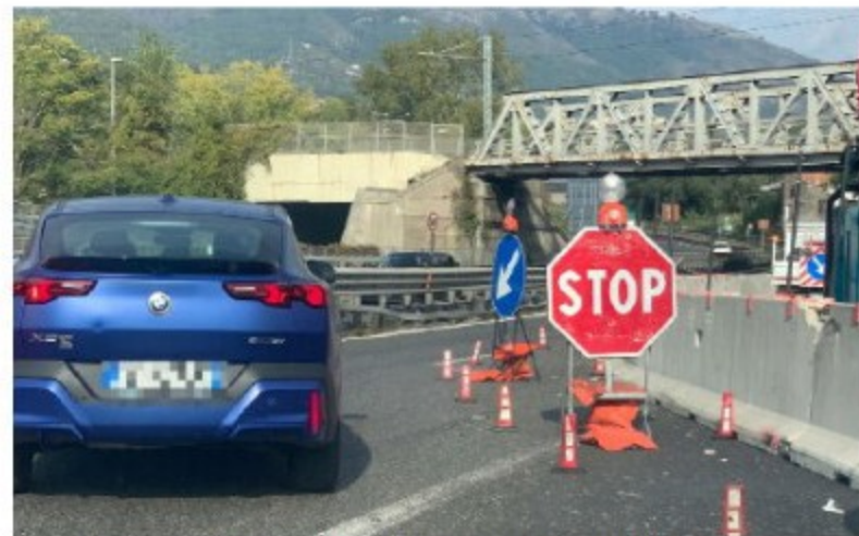
Il “mini cantiere” a Fratte che sta rallentando la viabilità
