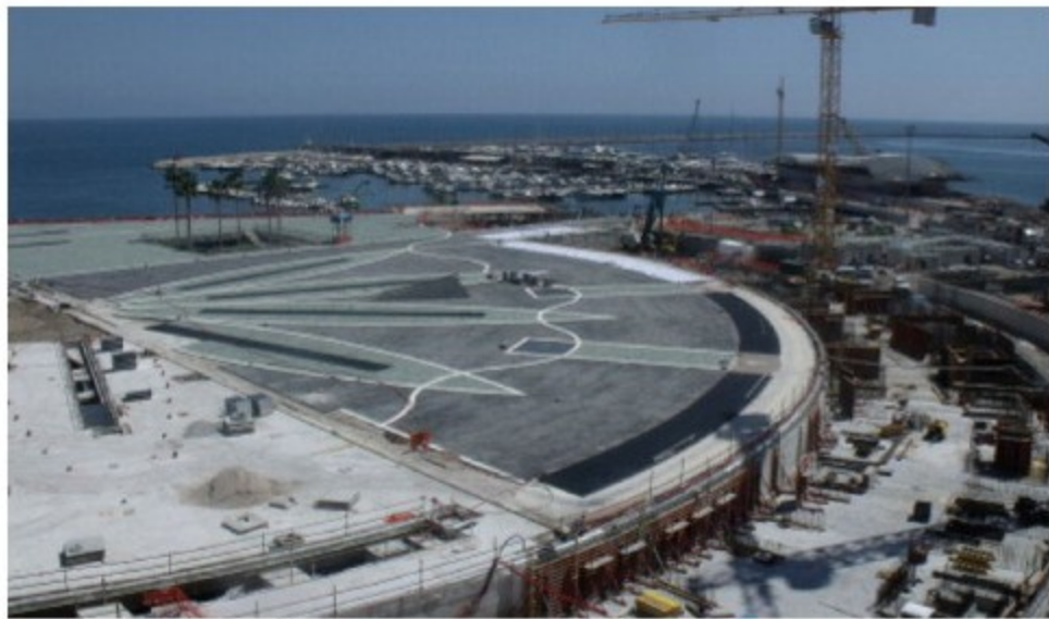
L'area di cantiere di Piazza della Libertà
