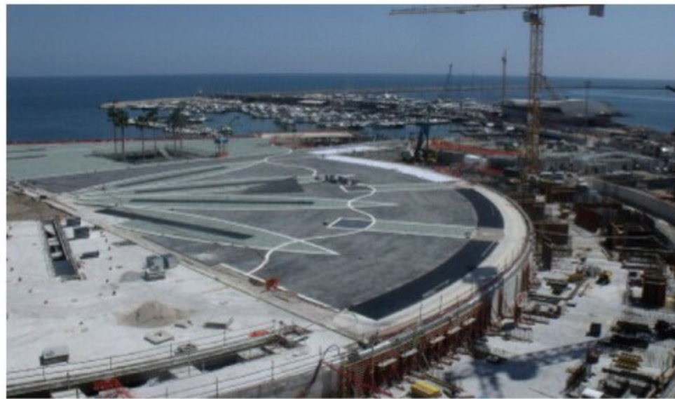
L'area di cantiere di Piazza della Libertà
