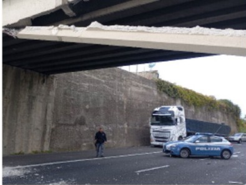
La trave sganciata dopo l'impatto sul Raccordo; a destra, l'auto travolta dai detriti
