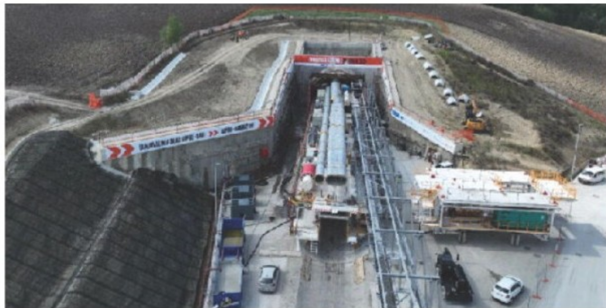
Un cantiere dell'alta velocità Napoli-Bari
