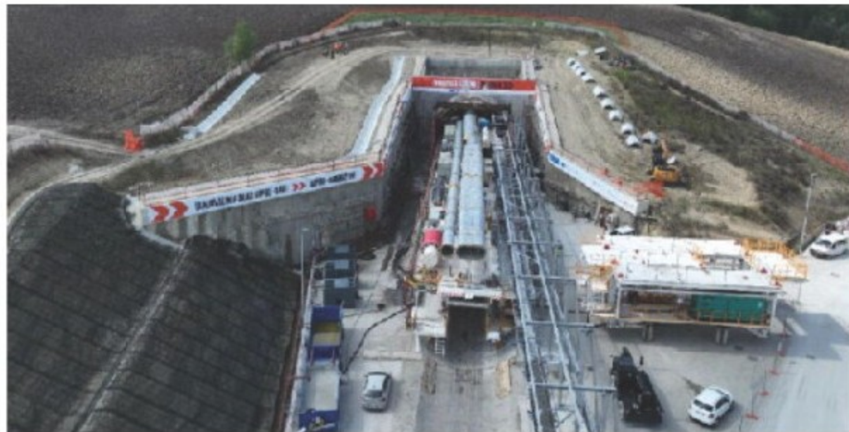
Un cantiere dell'alta velocità Napoli-Bari
