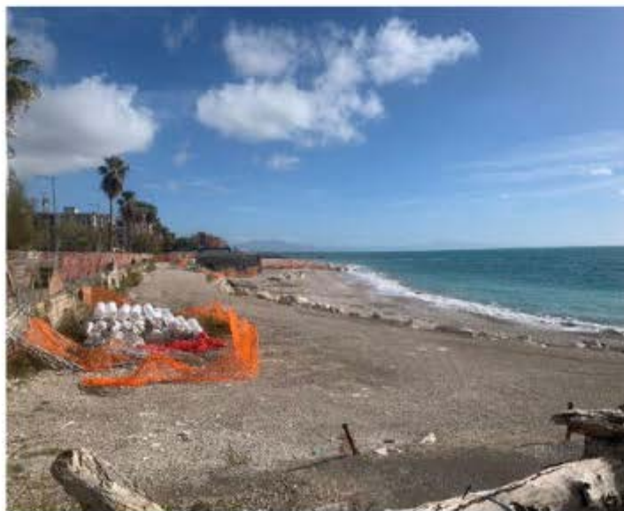
L'area del cantiere del ripascimento fra Pastena e Torrione
