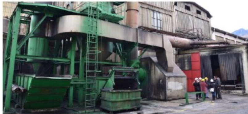
Lo stabilimento industriale di Fratte
