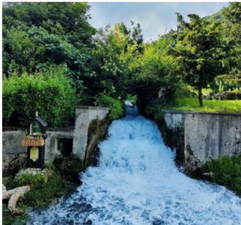
Il fiume Sarno in località Foce
