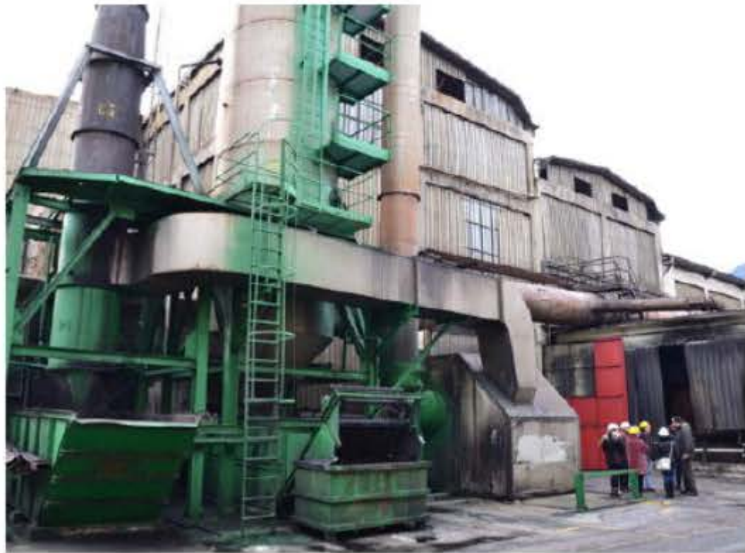
Lo stabilimento delle Fonderie Pisano di Fratte
