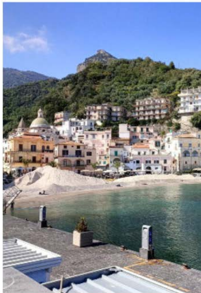
Il cantiere del ripascimento a Cetara
