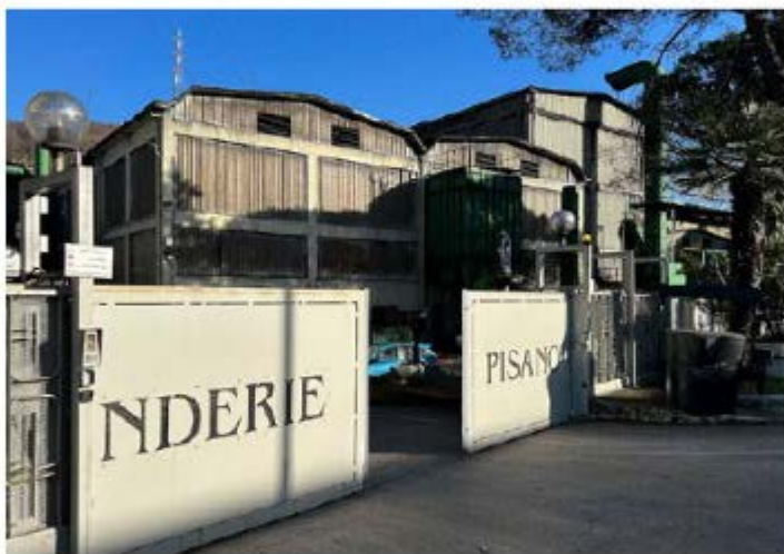
L'Ingresso dello stabilimento delle Fonderie Pisano
