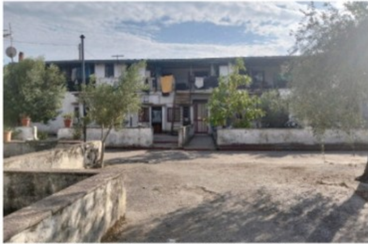
Una parte del “Palazzo”, la struttura della Piana del Sele che ospita 150 lavoratori agricoli, molti dei quali “fantasmi”
