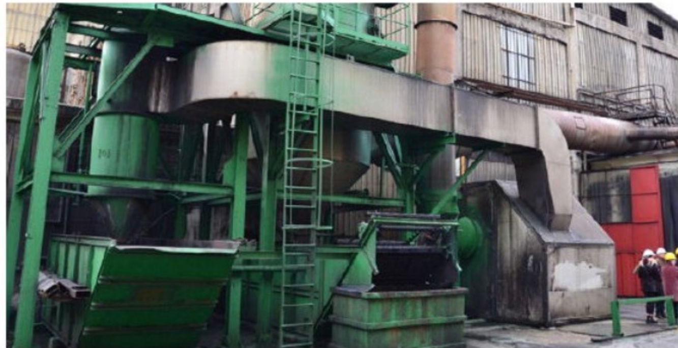
Uno dei capannoni delle Fonderie Pisano di Fratte
