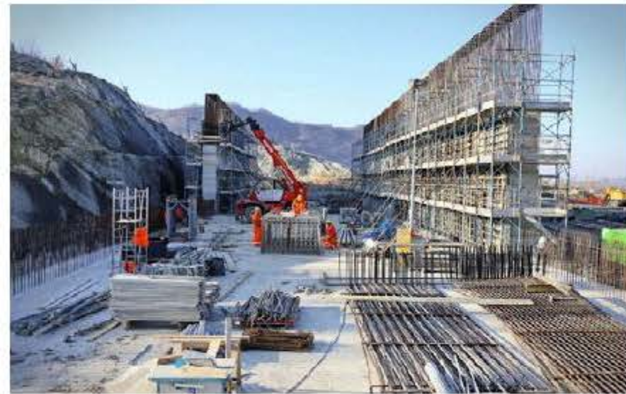
Un cantiere edile
