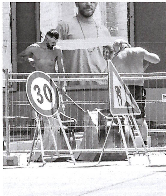
Operai al lavoro in strada a Torino
