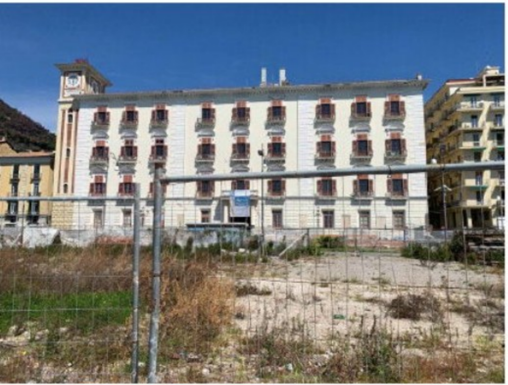
Area di piazza Cavour
