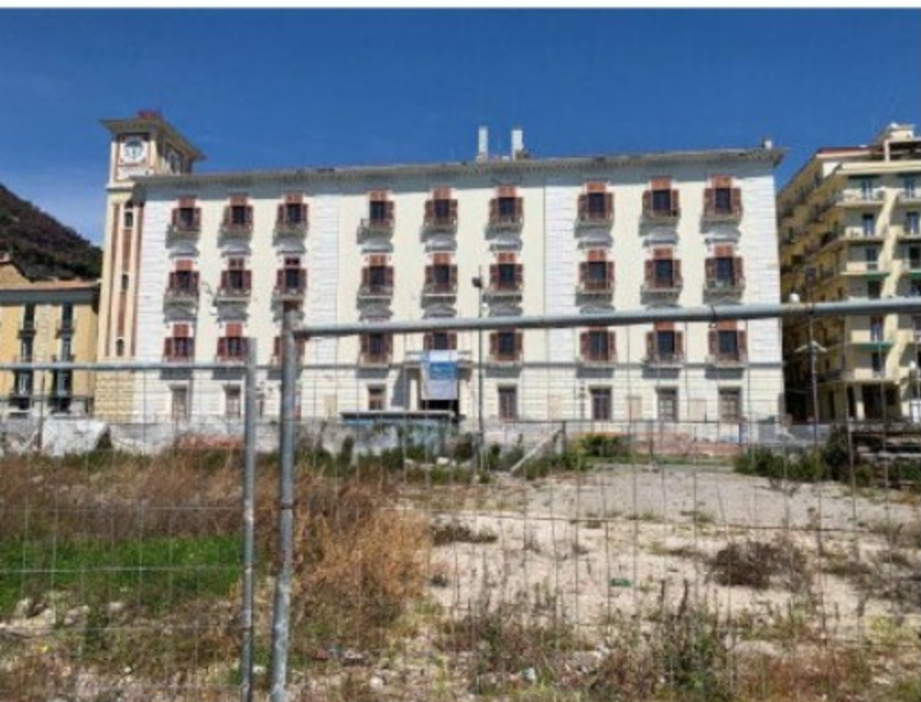
Area di piazza Cavour
