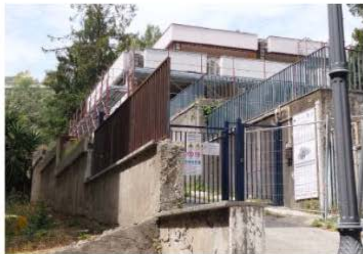
I lavori alla "Abbagnano" di via Cesare Battisti
