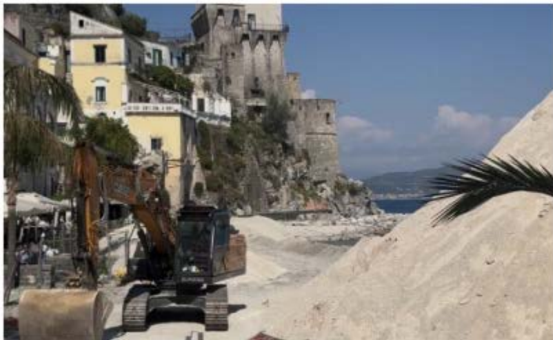
Il cantiere per il ripascimento della spiaggia a Cetara
