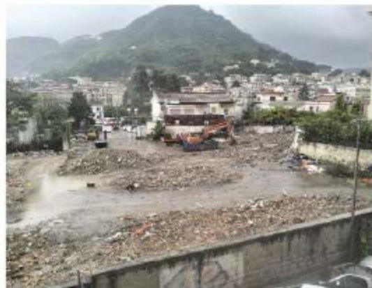
Il cantiere dell'ex Di Mauro a Cava de' Tirreni
