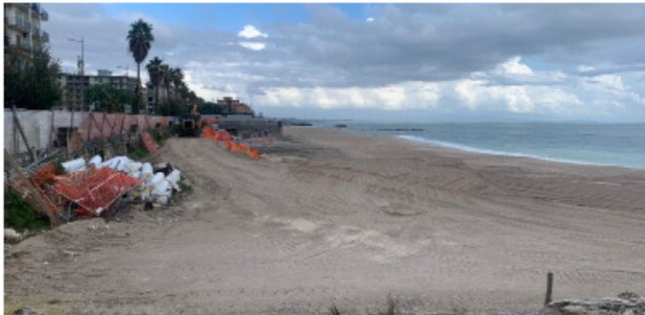
I lavori di ripascimento tra Torrione e Pastena sono stati bloccati
