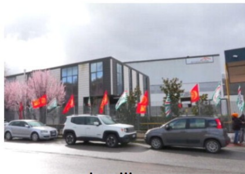
Lo stabilimento ex Arcelor Mittal di Luogosano, in provincia di Avellino
