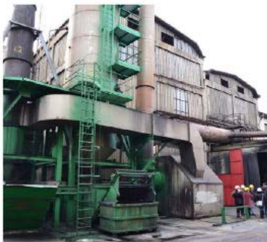
Lo stabilimento industriale di Fratte
