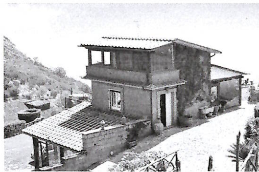
● Il resort di Sorrento demolito su disposizione della Procura
