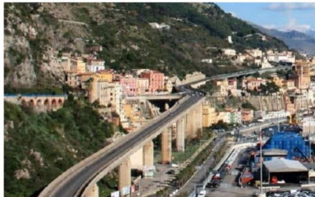
Il viadotto Gatto
