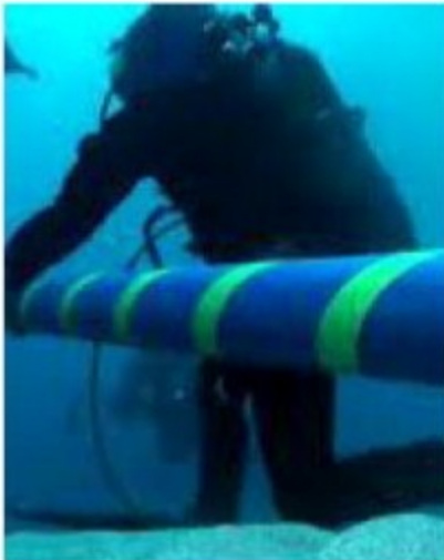
L'intervento di Terna
