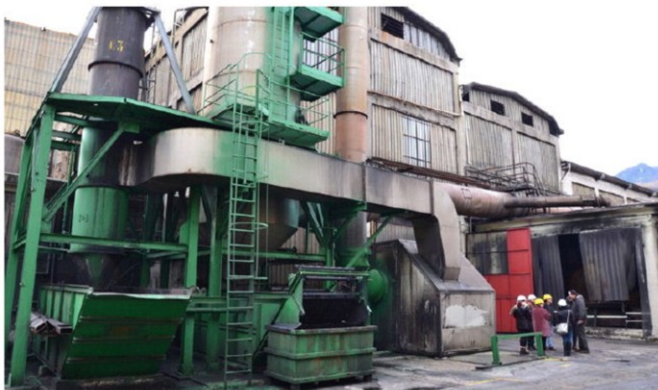
Lo stabilimento industriale di Fratte
