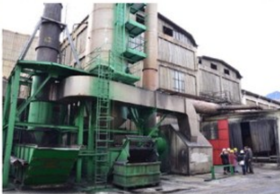
Le Fonderie Pisano; a destra, l'ingegnere Ciro Pisano con gli operai dello stabilimento di Fratte
