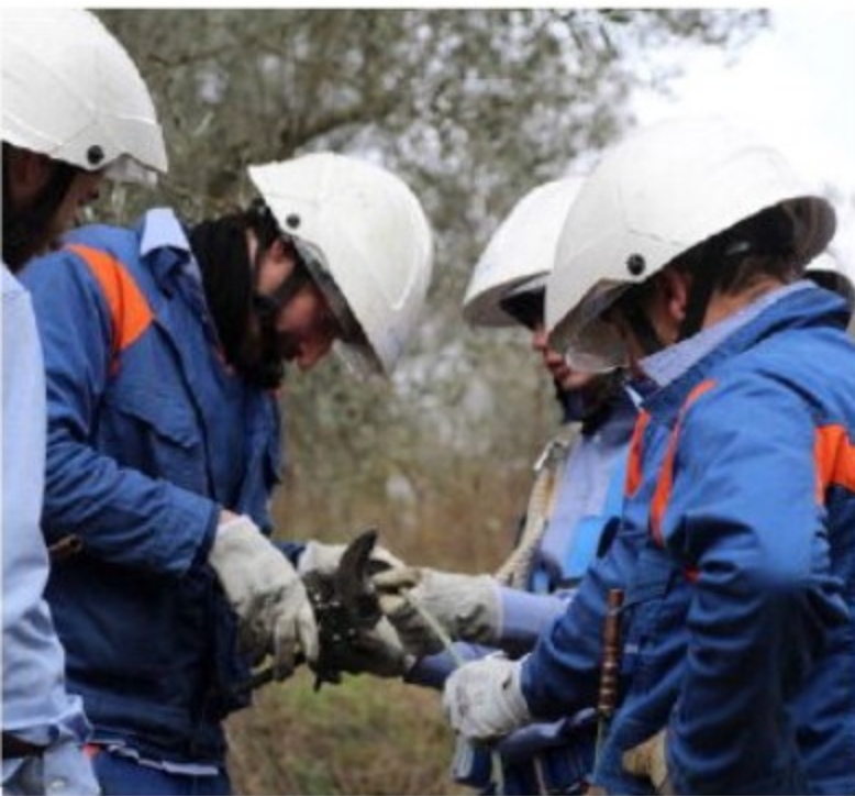
Gli operai dell'Enel all'opera sul territorio di Mercato San Severino
