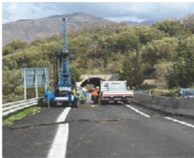
Il cantiere che preoccupa gli operatori turistici.
