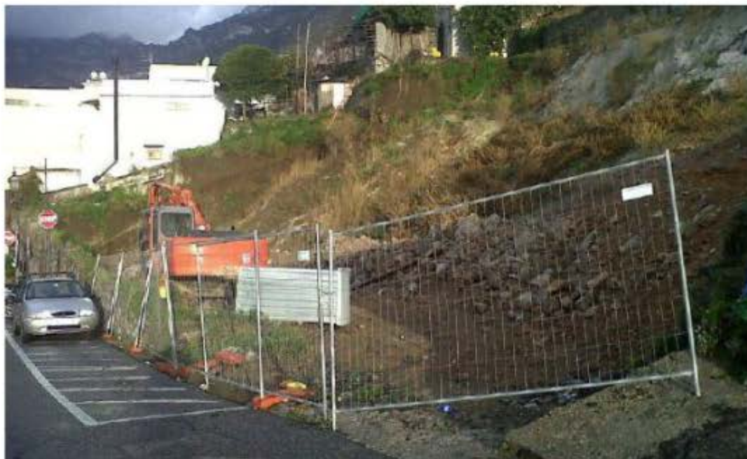
Il parcheggio di via Marconi potrà essere realizzato a Praiano
