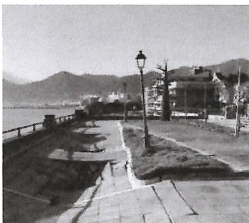
Il crollo a Torrone
