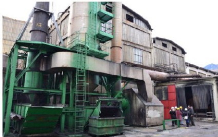
Lo stabilimento di Fratte delle Fonderie Pisano
