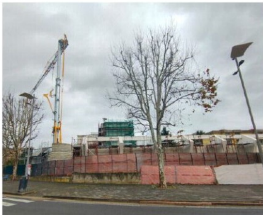
La mini-palestra in corso di costruzione a Mariconda
