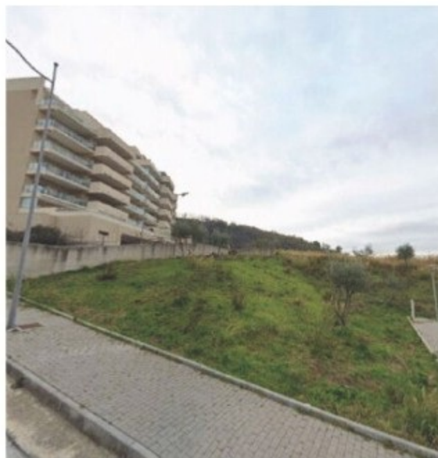
L'area di Brignano in cui sarà realizzato il nuovo albergo a quattro stelle
