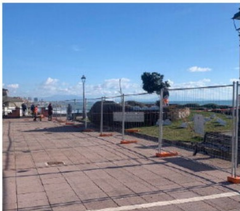
Il lungomare di Torrlone interdetto dopo gli ultimi crolli
