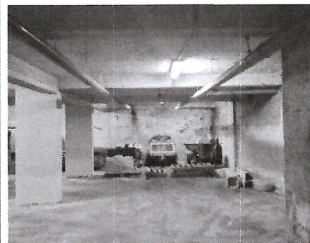
Uno scorcio del deposito comunale di Nocera Superiore
