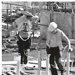
Operai al lavoro
