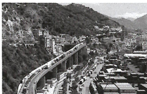
Il viadotto Gatto di Salerno
