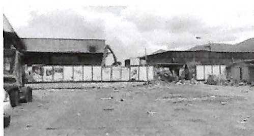
Il sito di stoccaggio rifiuti ex Helios di Scafati e ora della società Seneca
