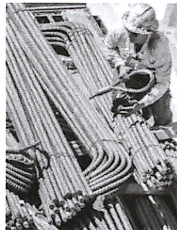
Un operaio al lavoro con dei cavi di acciaio in un cantiere
