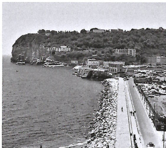
▲ Il porto turistico Il progetto prevede una scogliera di protezione, strutture moderne e uffici
