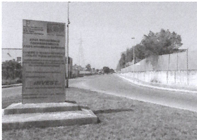
L'ingresso nell'area industriale di Fosso Imperatore
