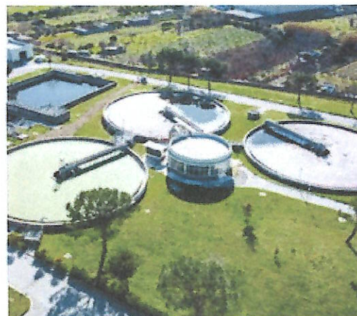
Il depuratore di Nocera Superiore
