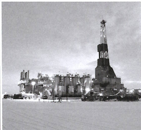
▲ L'impianto La piattaforma di Nikaitchuq, in Alaska, ceduta da Eni a Hilcorp
