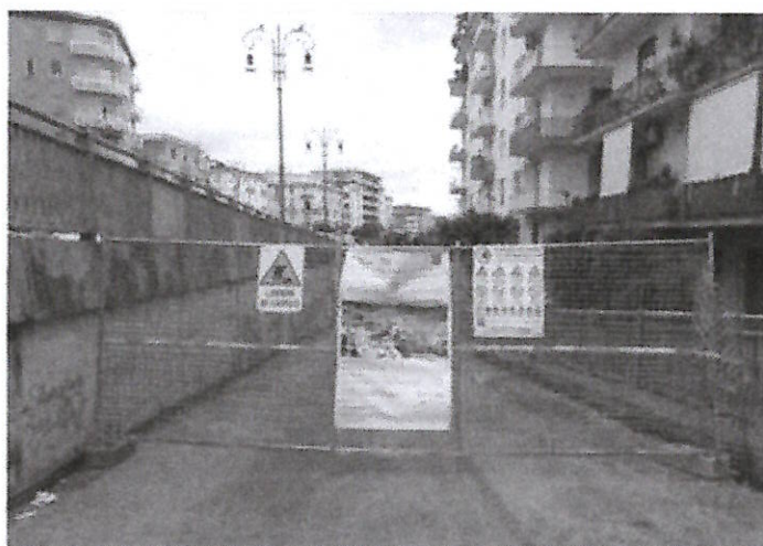
Il cantiere per il completamento dell'area est del trincerone ferroviario
